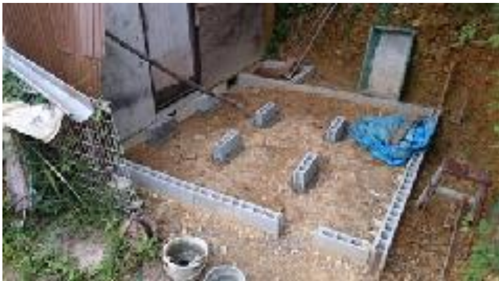
基礎工事:重量ブロック1段
