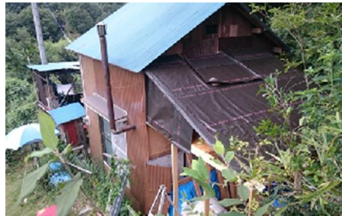
ルーフィング: 2017.9.xx 防水、防湿、防滴 台風が来ても雨漏れなし
