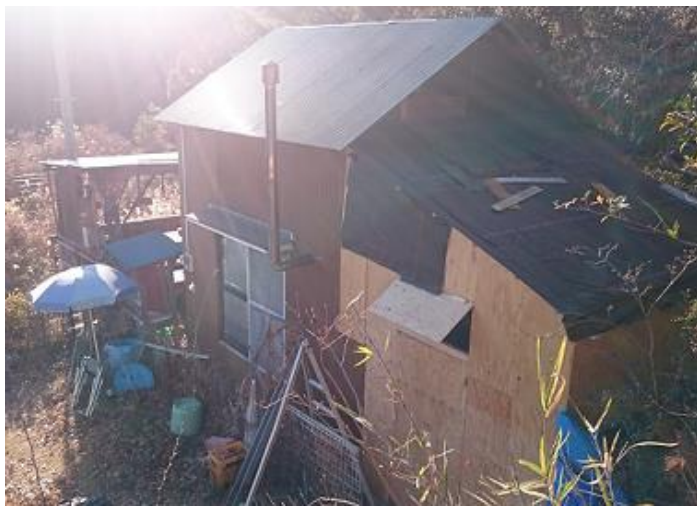
壁材として9mm厚の針葉樹合板を貼って生地完成。 2018.1.7
