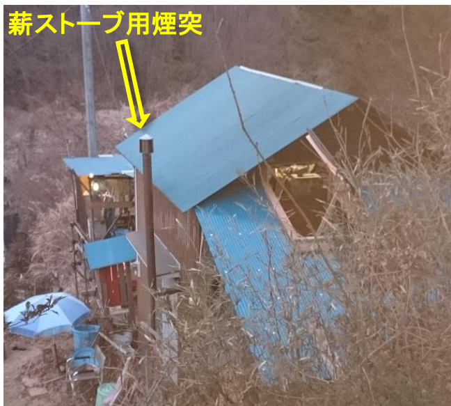
波板を葺き、保守管理用のハッチを作る
