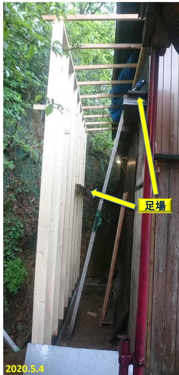
柱立て完了 柱支えのための補助版は取り外し
