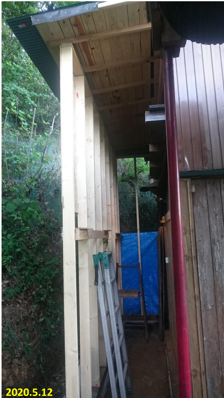
OSB合板 上半分 外壁:最安(貧乏人が建てる基本)
