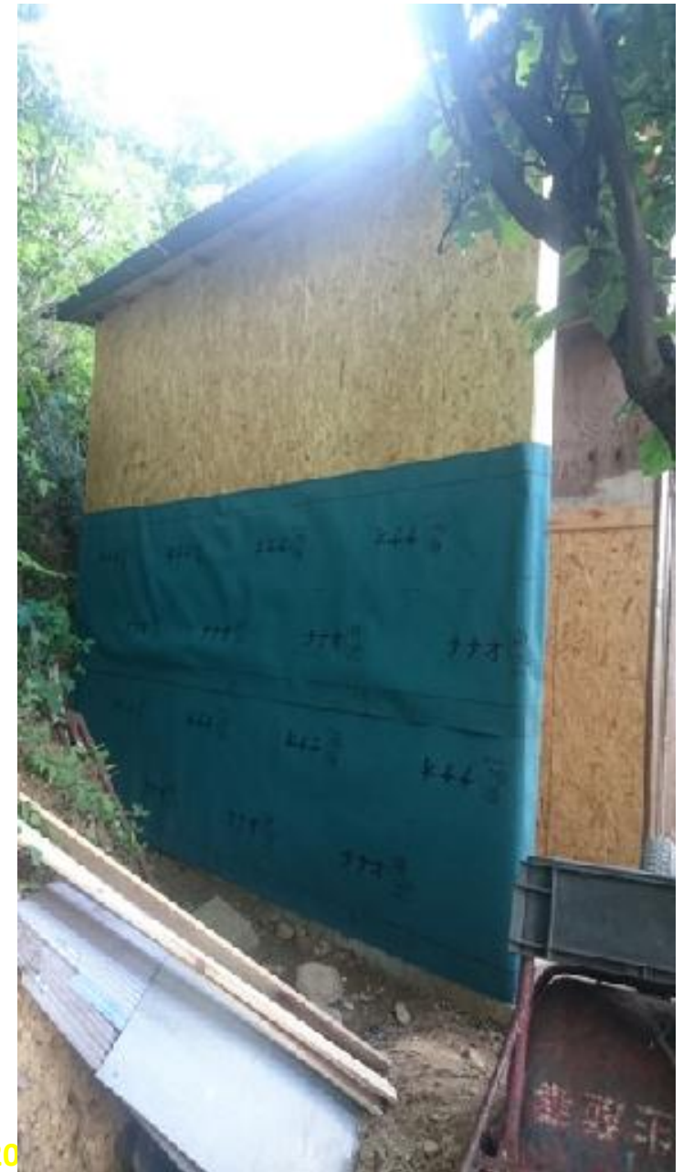
アスファルトルーフィング下半分 雨だれからの“下はね”に対応
