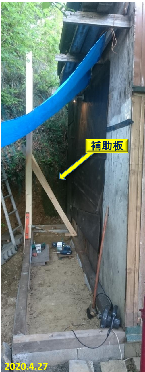
柱立て 完全に1人のため補助板使用
